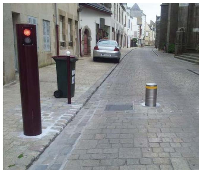
Borne rétractable semi automatique :
